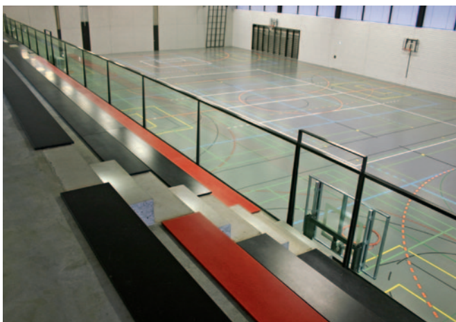
Absturzsicherung einer Zuschaueranlage mit Verbund-Sicherheitsglas, freie Sicht auf die Spielfelder
