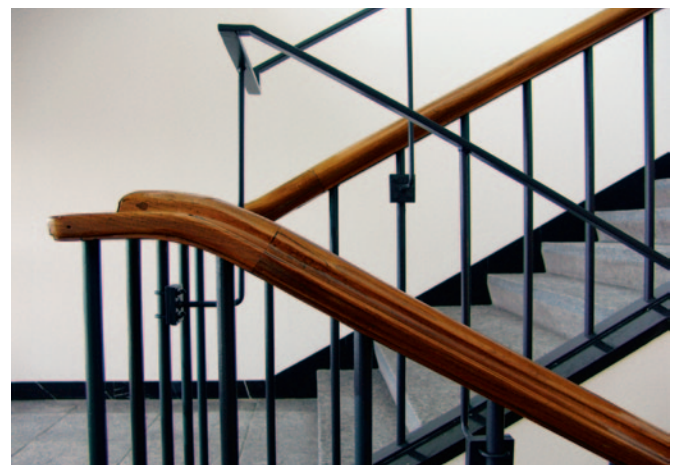
Nachrüstung in einem historischen Bau durch Anbringen eines erhöhten Handlaufs
